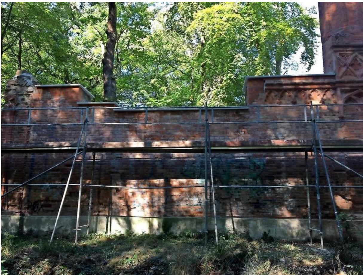
Sandsteinplatten schützen das Mausoleum im Sundern jetzt vor Regen und Frost. Quelle: privat
